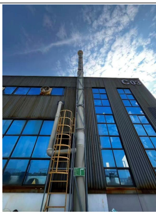
氧化铅破碎、筛分、包装废气排放口（DA007）
