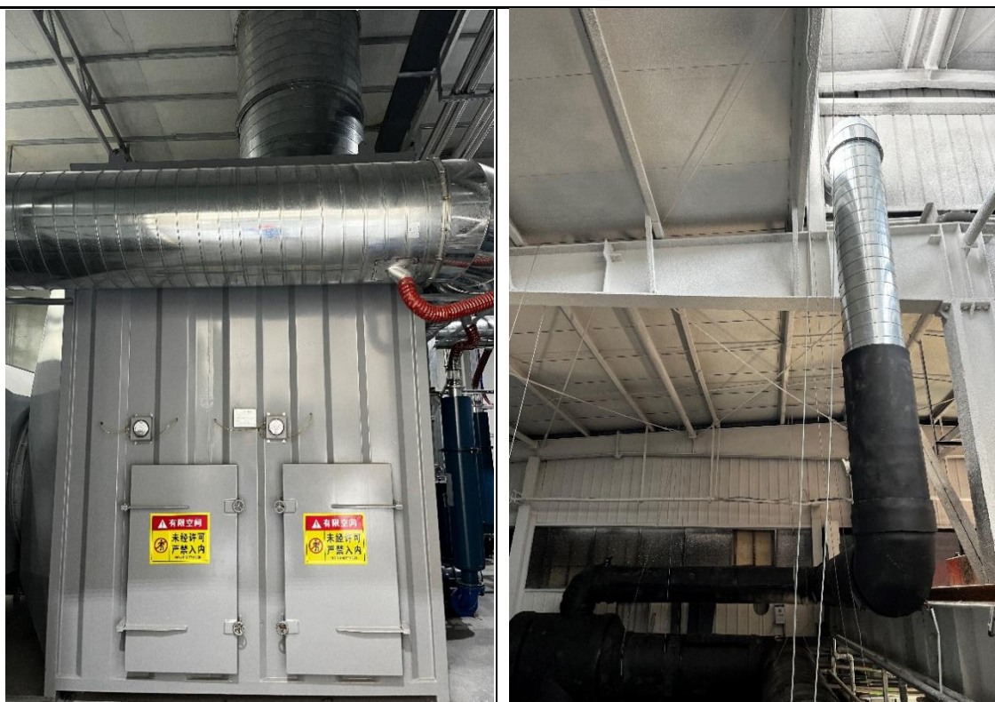
氧化锆破碎、筛分、包装废气排放口（DA006）
